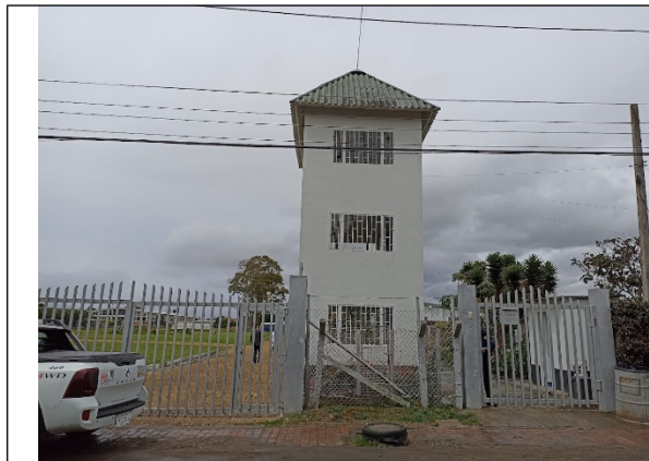
Foto No. 1. Fachada del predio.
